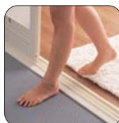
段差のない出入口口
