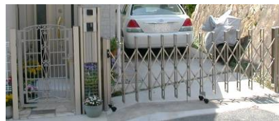
機能門柱・伸縮門扉新設
